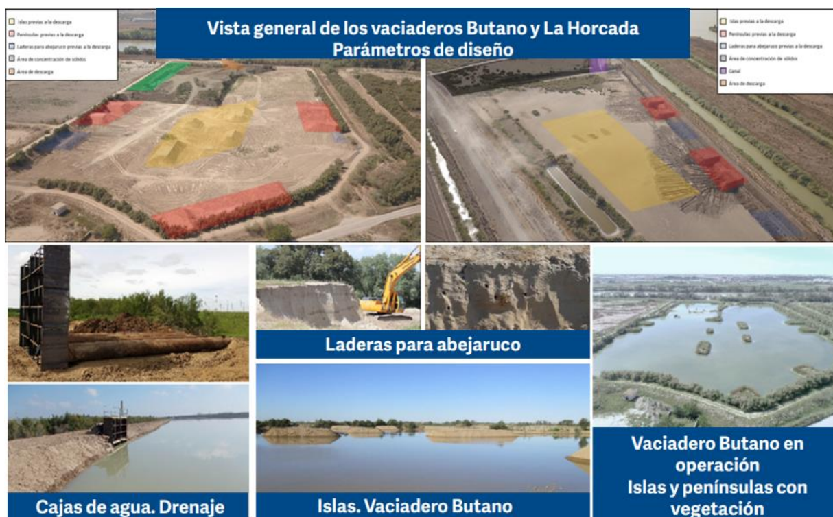
Ilustración 12. Secuencia de los trabajos realizados en los vaciaderos de Butano y La Horcada. Fuente: APS
